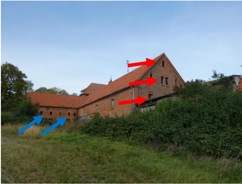
Abbildung 5: Giebelfenster mit Holzladen und Einflugspalte (roter Pfeil), Verschluss Fenster (blauer Pfeil) – Süd- und Westseite
