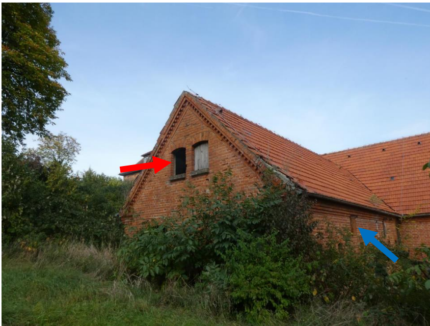
Abbildung 5: Giebelfenster mit Holzladen und Einflugspalte (roter Pfeil), Verschluss Fenster (blauer Pfeil) – Süd- und Westseite
