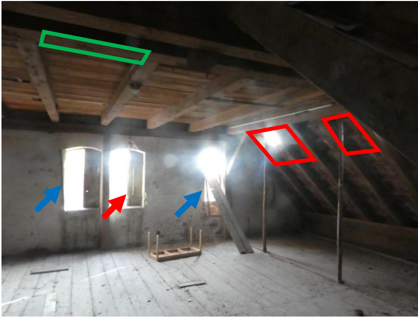
Abbildung 9: Fledermausquartier im Sparrenfeld (rote Umrandung), 4 Leichtbeton-Hohlblocksteine (grüne Umrandung), Giebelfenster mit Holzladen und Einflugspalte (roter Pfeil), Verschluss Fenster (blauer Pfeil)
